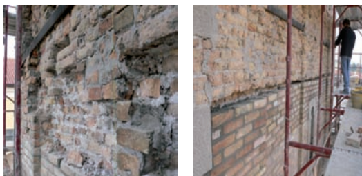
Particolari delle esecuzioni dei lavori.
